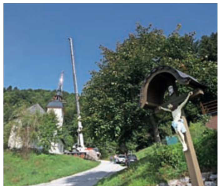
Namestitev štiri tone težke kupole na vrh zvonika je potekala brez zapletov. FOTO: GORAZD KAVČIČ
